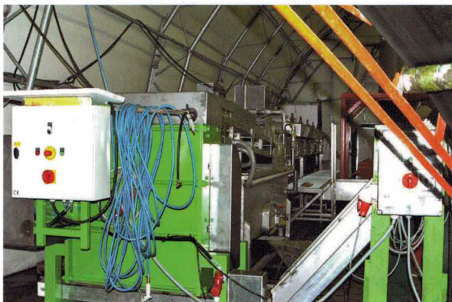
Teilbereich der florafuel®-Anlage (Testumgebung)
